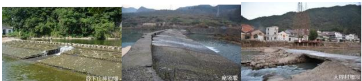
现状堰坝照片
